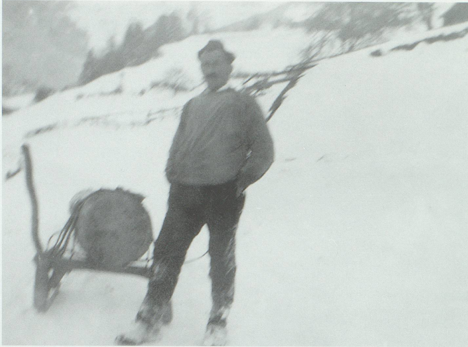
Abb. 26. Mit dem «Handtuu»s führte ein Holzer einen Baumstamm auch durch gefährliches Gebiet talwärts. Der an der rechten Kufe und «Nase» befestigte Sparren diente der Steuerung des Gefährts. Das Bild, auf Prestenegg, Studnerberg, entstanden, zeigt Hans Vetsch (1896–1966), «dr Stutzis Hans». Er war so durch die steile Läui herabgekommen. Bild bei Mathias Vetsch, Obergatter, Grabs.
