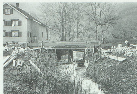
Bau der Steinenbach-Brücke in Sennwald (1935).
