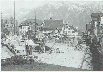
Tieferlegung der Staatsstrasse beim Buchser Rathaus (1935/36).
