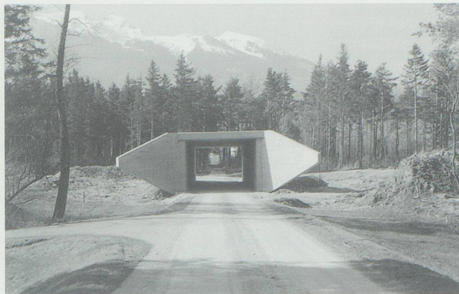
Obwohl die N 13 optimale topographische Voraussetzungen hat, waren dennoch Kunstbauten für Unter- und Überführungen notwendig. Im Jahre 1977 stand diese Unterführung noch als «Fremdkörper» im Alberwald bei Weite. Bild: Abteilung Brückenbau.
