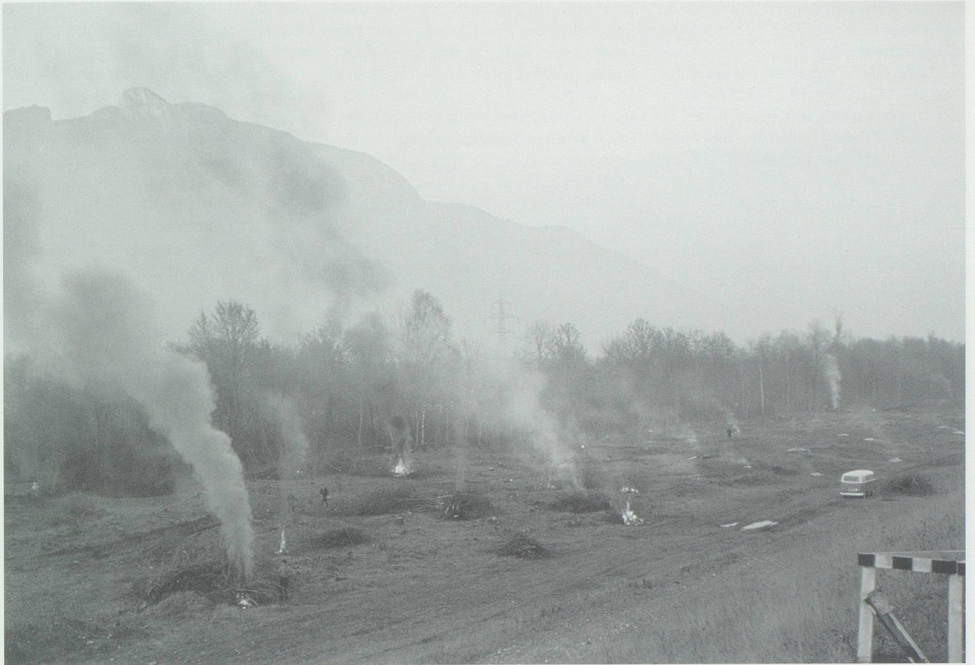
Im Bereich Haag-Salez-Sennwald wurden im November 1964 der Auwald gerodet und die Fläche planiert.
