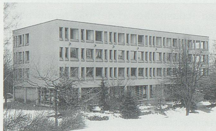
16. Februar: Der Zweckverband Pflegeheim Werdenberg beschliesst eine umfassende Sanierung des Pflegeheims in Grabs.
