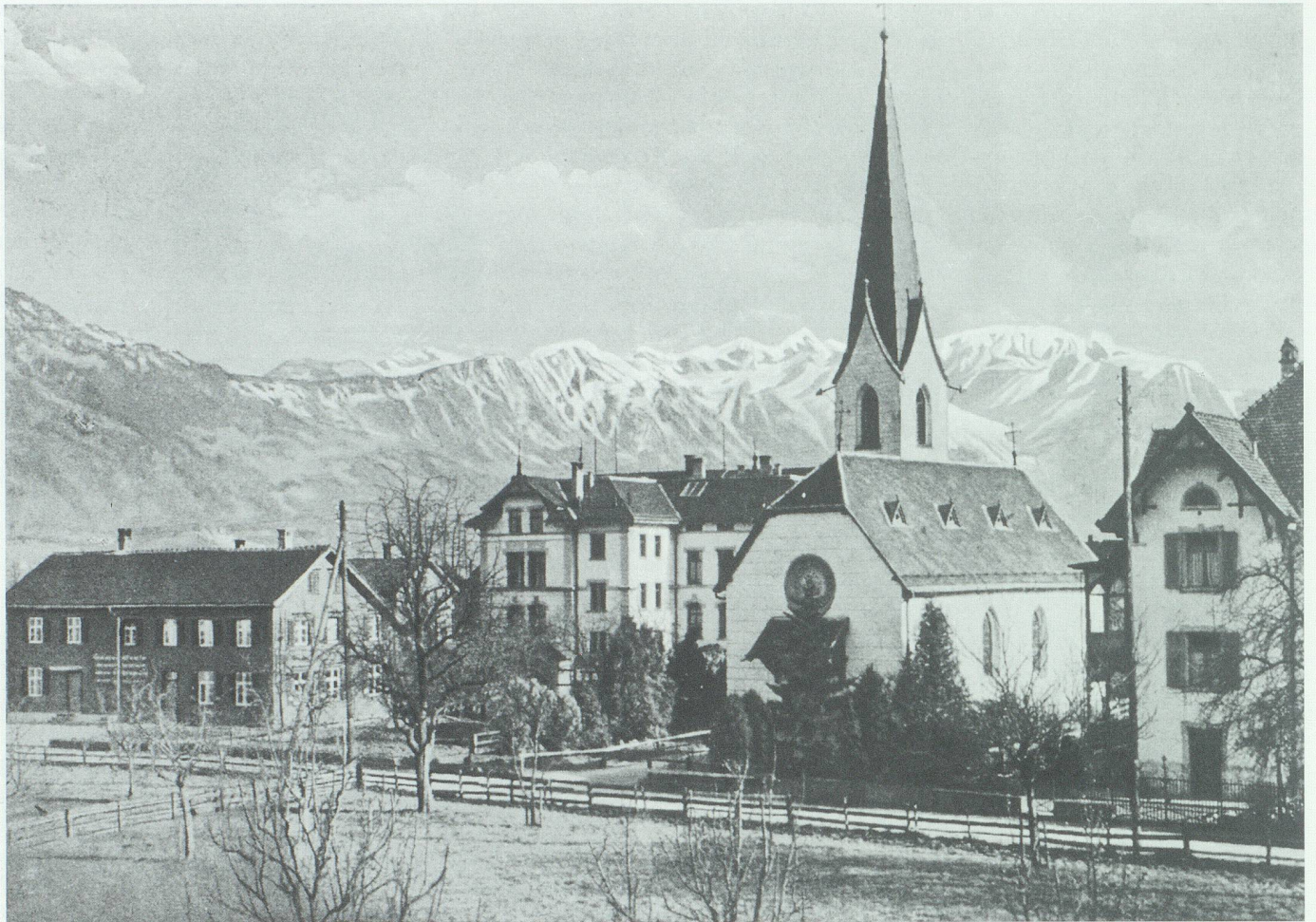
Katholische Kirche Buchs, gebaut 1896. Hinter der Kirche das Schulhaus, daneben das von Pfarrer Künzle kurz entschlossen gekaufte Stickereihaus von Arnold Kägi. Bild aus Gschwend 1915.
