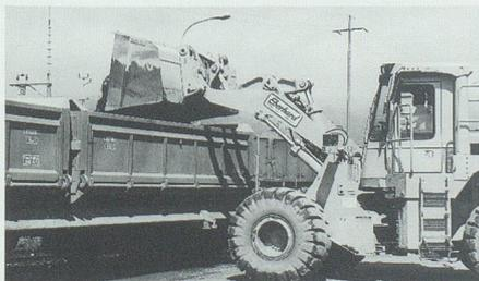
Rund 11500 Tonnen överschmutztes Kies werden ausgehoben und gereinigt. Die Sanierung kostet rund 1 Million Franken.
