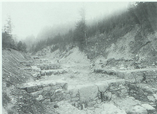
Massive Blockmauern stabilisierten das Bachbett der Simmi, konnten aber den Materialtransport von oben nicht aufhalten. Bild von 1891/92 im Staatsarchiv St.Gallen.
