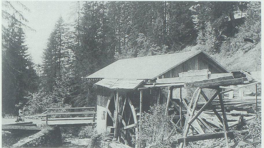
**Sägemühle mit überschlächtigem Wasserrad und Kett, um 1900; Standort unbekannt. Bild bei Hans Senn, Weite.**
