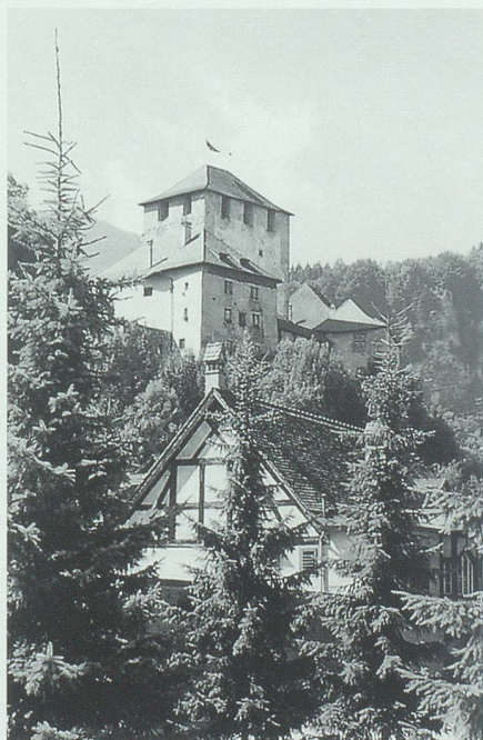
Die Feldkircher Schattenburg. Bild im Vallaster-Archiv.
