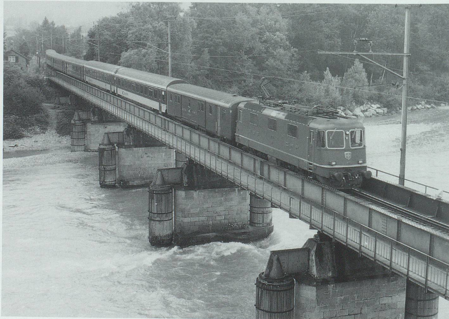
Die 1928 gebaute eiserne Nachfolgerin der Holzbrücke, deren Pfeiler weiterhin verwendet wurden. Bild 1992: Tibert Keller, Trin Station.
