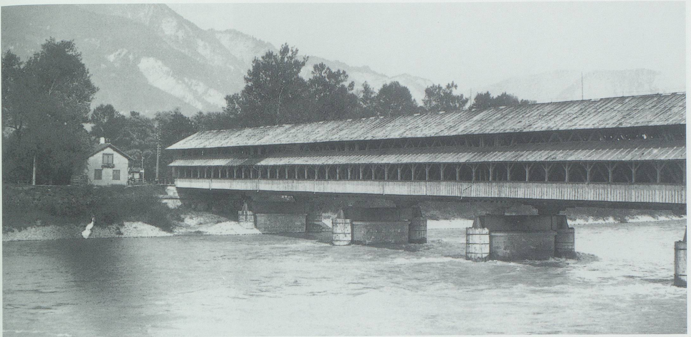
Auf der Nordseite wurde einige Jahre nach dem Bau ein gedeckter öffentlicher Gehweg angebracht. Deutlich erkennbar sind die charakteristischen Röhren- und Steinpfeiler. Die Brücke um 1900, aufgenommen vom Ragazer Fotografen Johann Fetzer. Bild aus Bärtschi-Baumann 1996.
