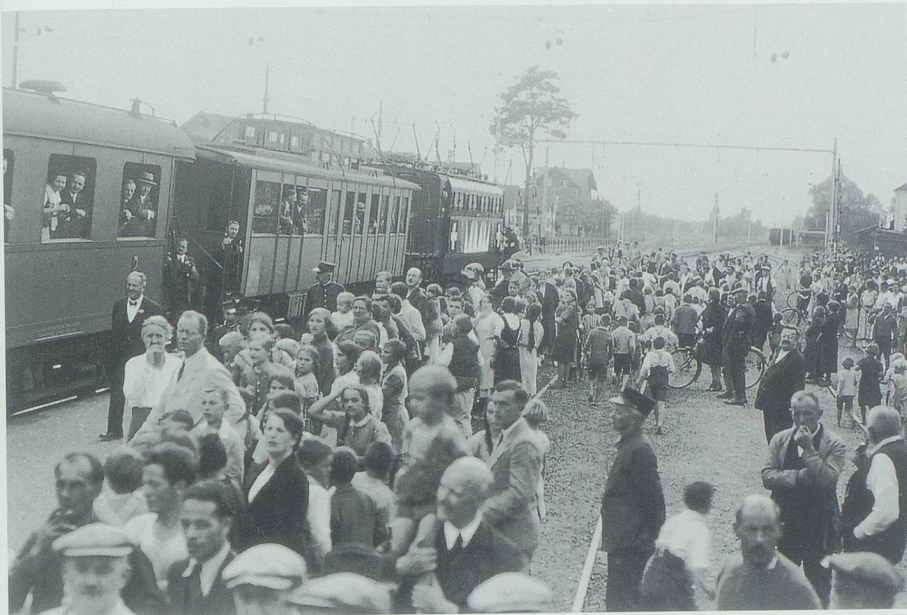
Freudentag am 21. September 1934 in Heerbrugg: Aufnahme des elektrischen Eisenbahnbetriebs zwischen St. Margrethen und Buchs. Der Festzug wurde von einer wappengeschmückten Ae 3/6 gezogen. Der Fahrleitungs-Beobachtungswagen, eingereiht unmittelbar hinter der Lokomotive, gehörte in der Regel zu den damaligen Eröffnungsfahrten. Bild in Sammlung Jakob Egli sel., Balgach.
