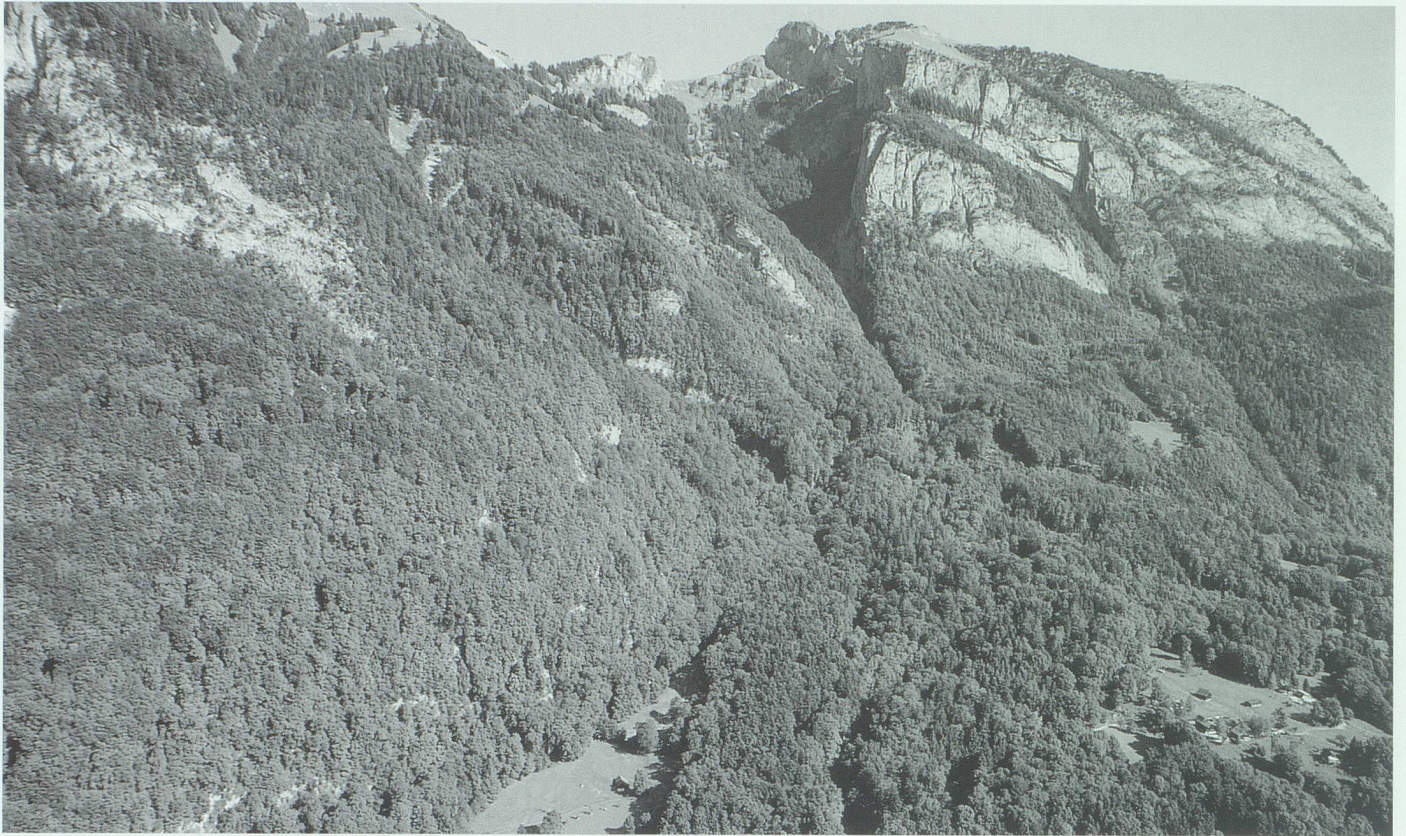
Schutzwald am Lögarterberg (links) und unterhalb des Hohen Kastens bei Sennwald. Erkennbar ist oben der Sammeltrichter und unten der teils bewaldete Schwemmfächer des Rohrbach-/Steinenbachsystems.
