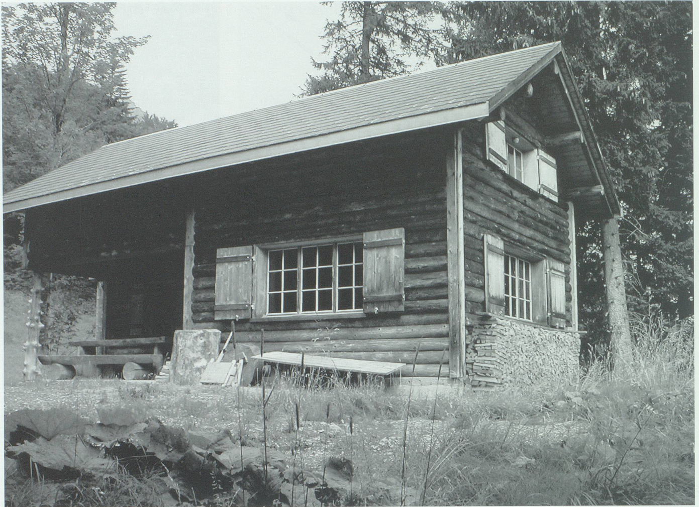
Neue und dauerhaft gebaute Holzerhütte am Weg zur Gletti, Wartau.
