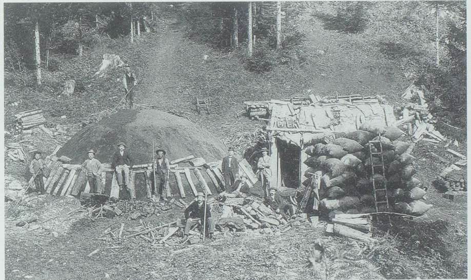
Köhler im Neuenburger Jura um 1890/1900: links der Kohlenmeiler; vor der Köhlerhütte (rechts) die gestapelten Säcke mit Holzkohle. Aus Hugger 1991.
