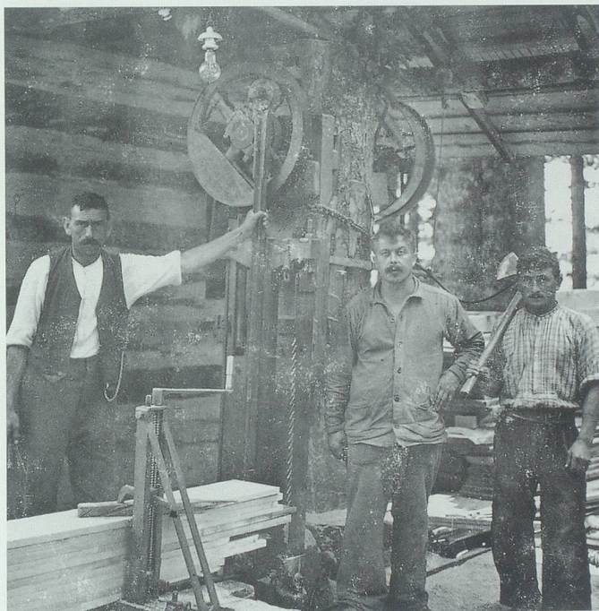
Die Waldsäge in Oberplättsch/Sevelen auf einer Aufnahme vom 10. September 1920 mit (von links) Baumeister Adolf Dünser, Stampf/Sevelen, Gallus Litscher, Schifflisticker, Gemeinde- und Kantonsrat, und einem Waldarbeiter (Name nicht bekannt). Bild: Sammlung Werner Hagmann, Zürich.
