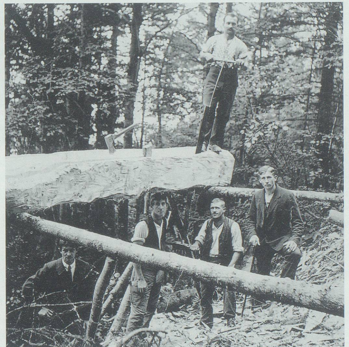
Noch in den ersten Jahrzehnten des 20. Jahrhunderts wurden Balken für den Bau von Alpgebäuden im nahe gelegenen Bergwald in anstrengender Handarbeit zugelegt, wie dies das Bild aus den 1920er Jahren dokumentiert. Es entstand anlässlich des Baus des Rieter Scherms im Rieterwald/Cholplatz (Gemeinde Wartau). Oben an der Säge Hans Heeb, Zimmermann, unten an der Säge rechts Jöri Schlegel und links Emil Caprez; ganz rechts (mit Stock) Baumeister Hans Schmidt. Bild in Privatbesitz.
