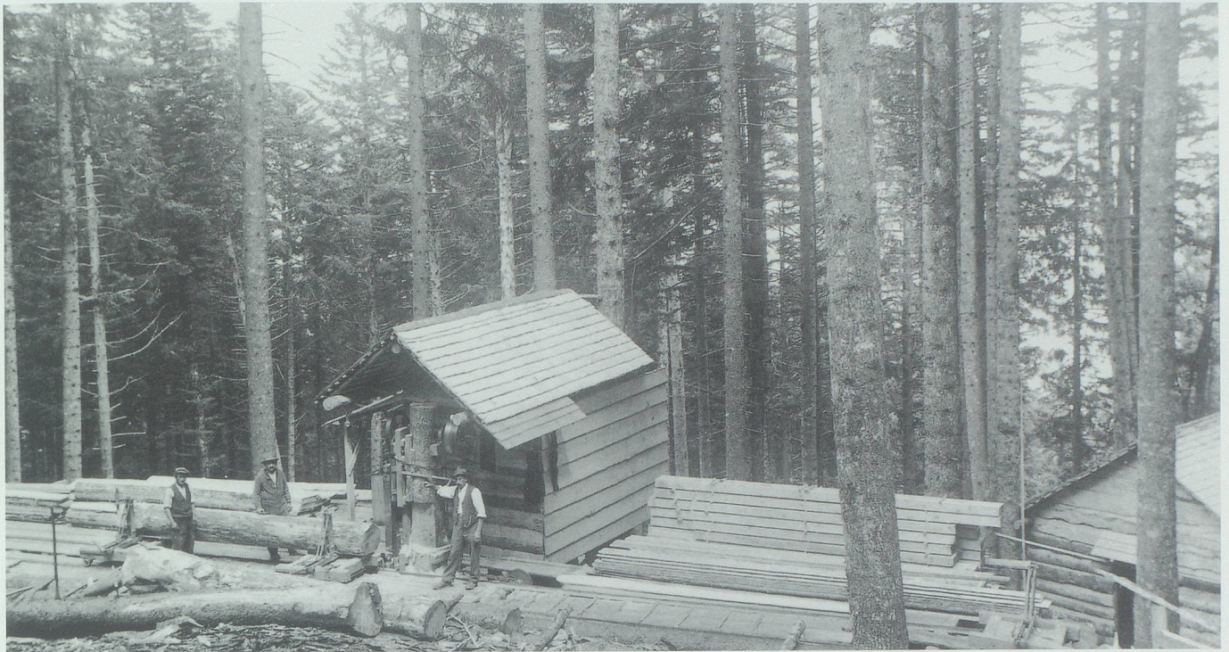
Der Einschnitt des Holzes für den Bau von Alpgebäuden erfolgte auch mittels sogenannter Waldsägen. Das Bild vom 21. Juni 1920 zeigt eine solche in Oberplättsch/Sevelen eingerichtete Anlage. Bild: Sammlung Werner Hagmann, Zürich.
