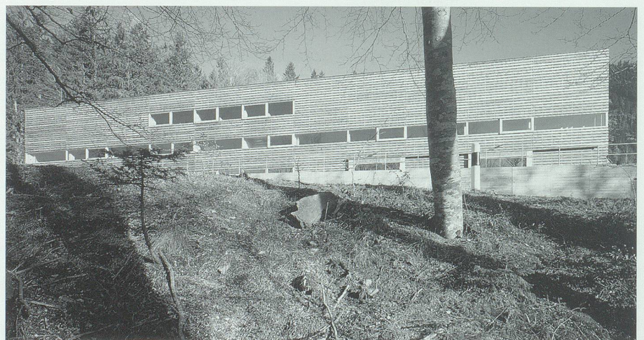
Abb. 3. Gemeindewerkhof Triesenberg (Architektengemeinschaft Ivan Cavagn/Franz Marock). Bild: Holzkreislauf Liechtenstein.
