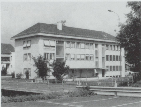
Verwaltungsgebäude der im Jahr 1901 gegründeten inter- nationalen Spedition an der Technikumstrasse, Buchs
