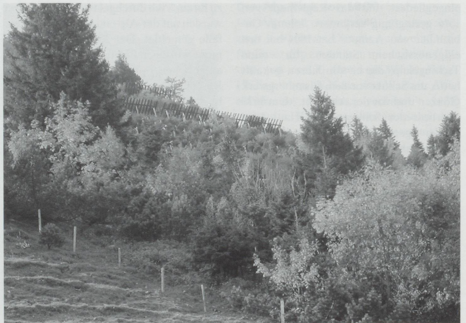
Lawinerverbauung und Aufforstung oberhalb Wang, im Anrissgebiet der Gonzenläui, die 1945 grosse Schäden anrichtete.
