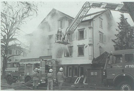
28. Februar: Der Grosseinsatz zur Brandbekämpfung am ehemaligen Hotel Werdenberg dauert bis gegen Mittag.
