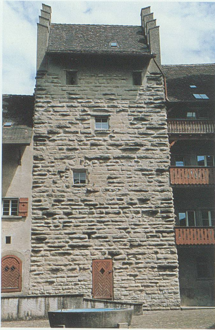
Abb. 38: Der Wehrturm der ehemaligen Burg Bürglen TG ist gut erhalten und besticht durch das sorgfältige Mauerwerk aus Buckelquadern. Der auf der rechten Seite anschliessende Palas wurde massiv umgestaltet.
