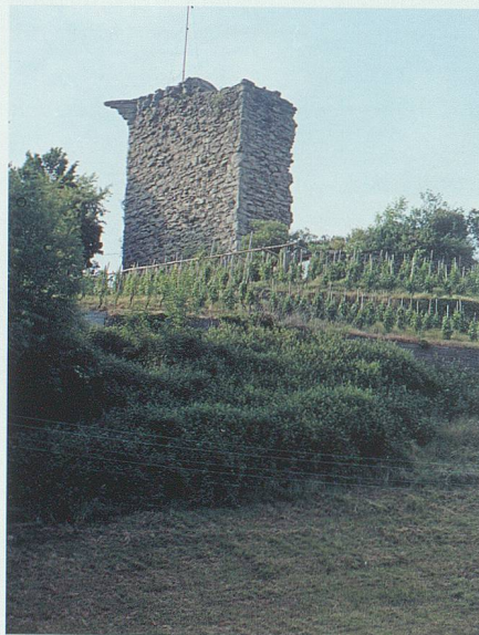
Abb. 34: Auf einem Hügelrücken, der von Westen gegen den Alten Rhein vorstösst, liegt die Ruine Alt-Rheineck. Weiter rheinwärts, unmittelbar über dem Städtchen, stand die heute völlig abgetragene Burg Neu-Rheineck.
