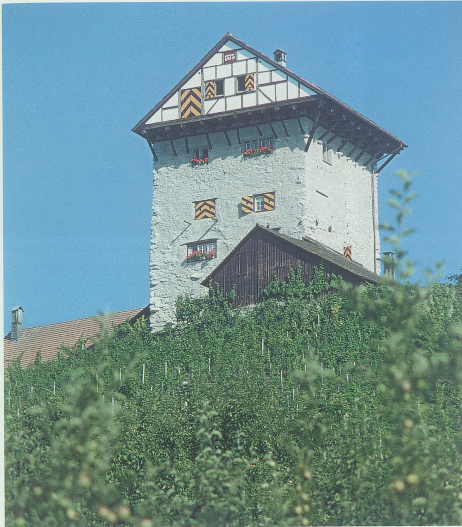
Abb. 20: Beim Wohnturm von Neu-Altstätten ist der vorkragende, hölzerne Obergaden erhalten, wie er auf vielen Burgen bestand. Die grossen Fenster im Turmsockel wurden später herausgebrochen.
