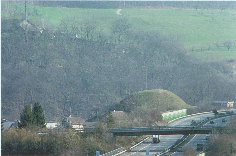
Abb. 6: Unmittelbar neben der A2 erhebt sich bei Zunzgen BL eine Motte, die einst wohl einen hölzernen Turm trug.
