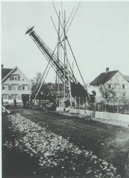
Montage eines Transformermastes im Jahr 1903 bei der Einmündung der Schulhausstrasse in die St.Gallerstrasse. Archiv Hansruedi Rohrer, Buchs
