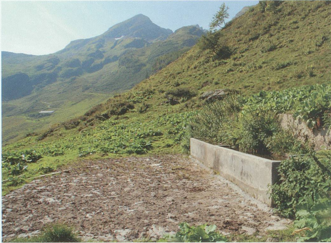
Auch der Mooseschlibrunnen ist mit einem befestigten Platz ausgestattet. Links hinten Imalschüel Mittelsess.
