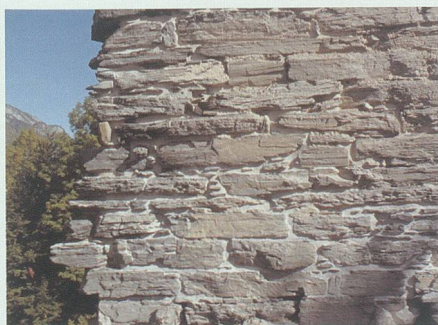
5. Oktober 2008: Die ausgefugten Mauern werden der Burgruine nun wohl für die nächsten fünfzig Jahre Halt und Sicherheit geben.
