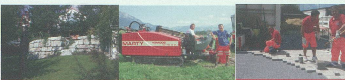
Grabenlose Rohrverlegung
