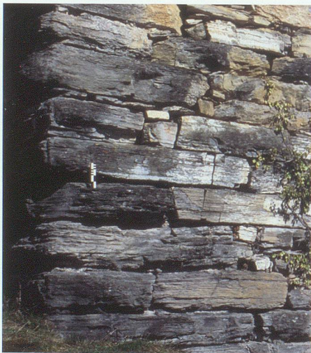
Abb. 4: Turm, Mauer M2. Senkrecht zur Schichtung geborstene Mauersteine neben der Ecke M2/M3, von S.
