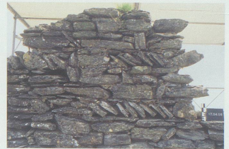
Abb. 36: Turm, Mauer M2. Lagen mit Ährenverband im nachträglich aufgesetzten Mauerwerk auf der Innenseite des zweiten Obergeschosses, von NNW.
