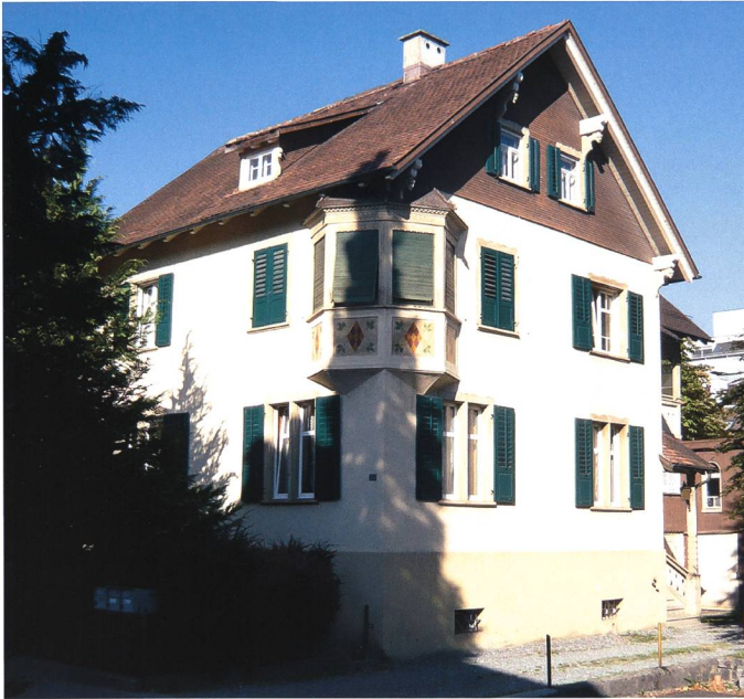
Johann Ploners Wohnhaus an der Schönfeldstrasse 2 in Buchs, 1912 von ihm selber geplant und erbaut.
