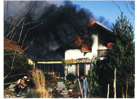
13. November: Beim Brand eines Wohnhauses in Rans wird das Obergeschoss vollständig zerstört.
