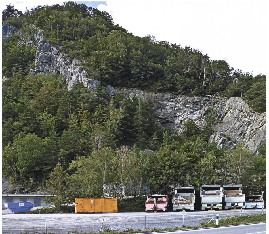
Im Gebiet der kleinen Hohwand haben Steinbruch und Festungsbau das Trasse ver-schwinden lassen: Die erhaltene Strecke nach Trübbach beginnt hinter dem liegenden Baum rechts oben. Foto Otto Ackermann, Fontnas
