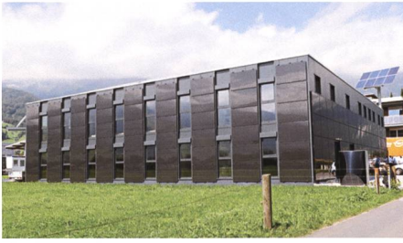
2. Dezember: Das Plus-Energie-Gebäude der Gamser Solarfirma Heizplan AG erhält den Europäischen Solarpreis.
