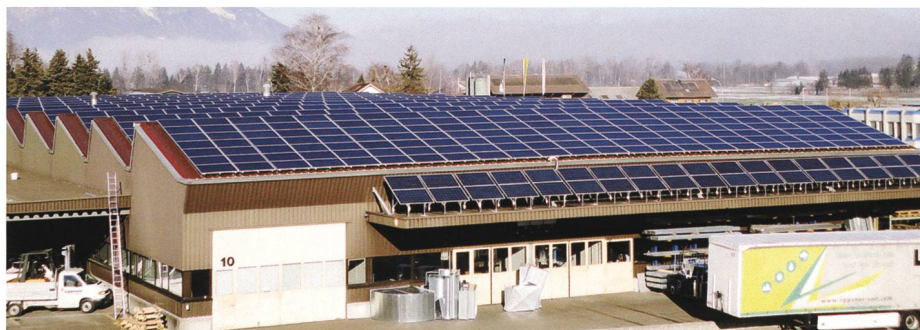
18. Januar: Die Fotovoltaik-Anlage der Lippuner Energie- und Metallbautechnik AG bringt Solarstrom für 60 Haushalte.
