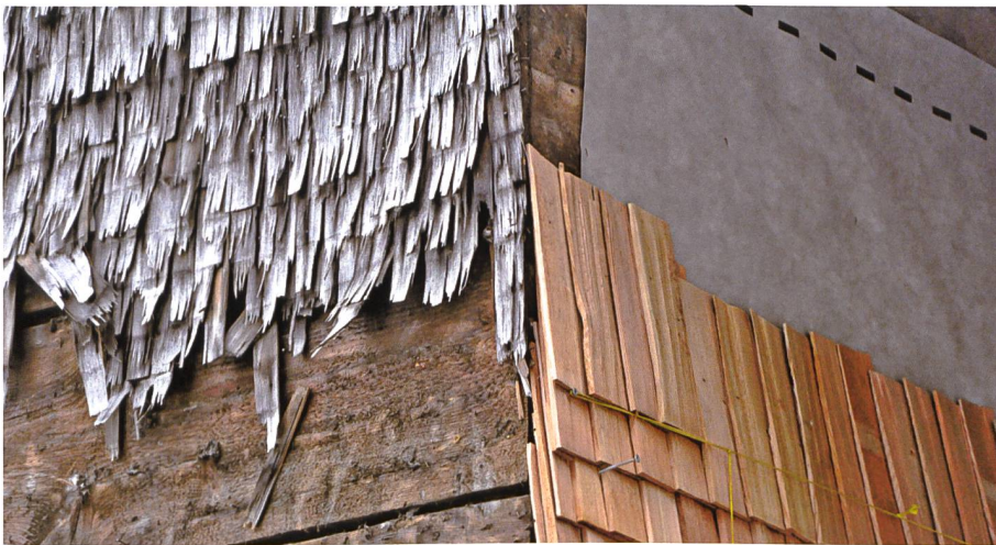
3. Juli 2012: Die alten Schindeln taugen nichts mehr, die neuen jedoch sind wetterfest.
