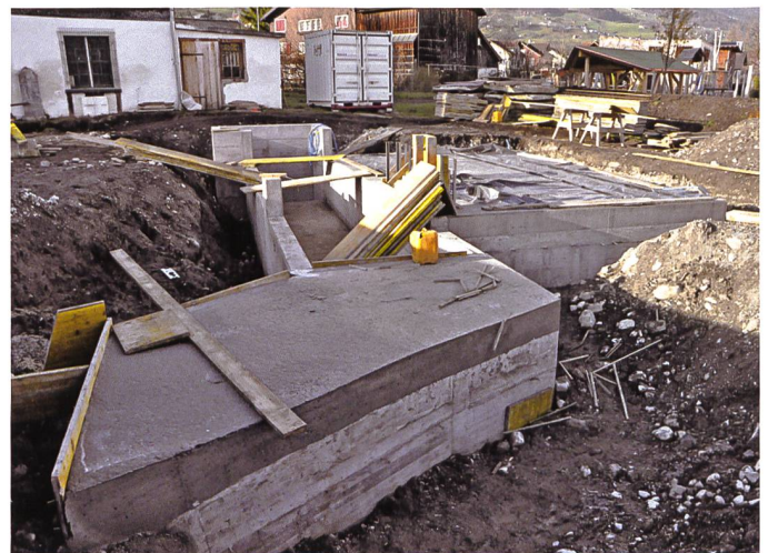
2. Dezember 2011: Der neue Kanal und das Fundament für die Messerschmitte stehen bereit.
