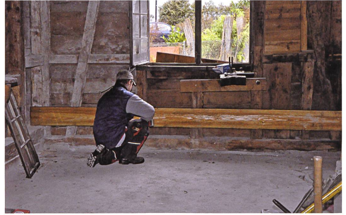
30. November 2011: Starke Verstrebungen mussten für den Transport angebracht werden.
