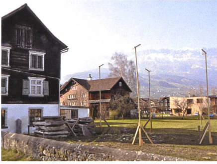
11. März 2011: Am neuen Standort am Grabser Mühlbach sind die Bauprofile gestellt.
