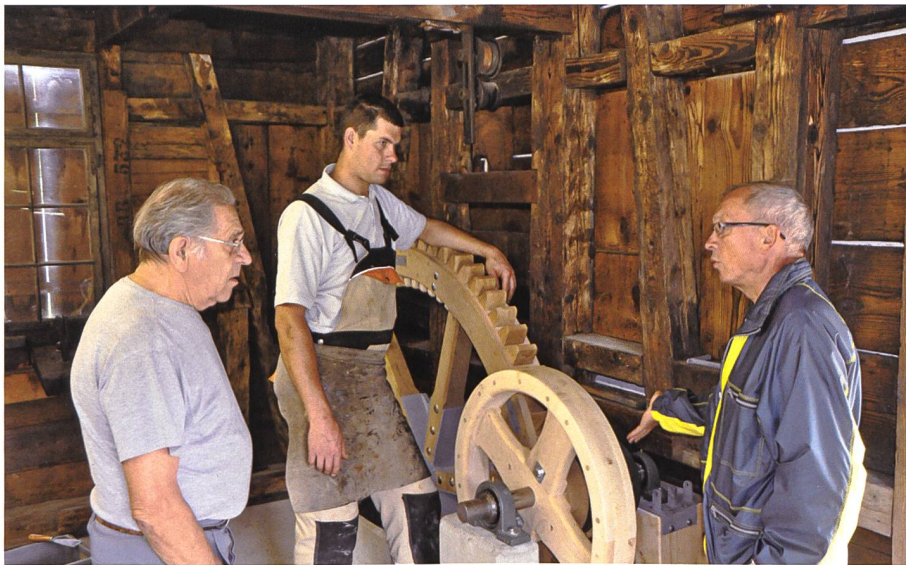
12. Juli 2012: Ernst Meier, Simon Oehrli und Walter Gantenbein (von links) lösen bei der Installation des Antriebs ein Problem.
