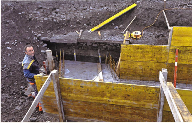
22. November 2011: Wo neu – der Kanal für die Messerschmitte – auf alt – den bestehenden Kanal – trifft.
