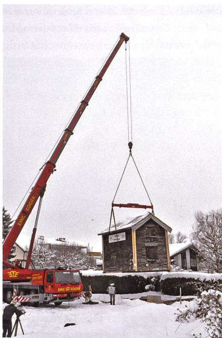
21. Dezember 2011: Der Kran hebt die acht Tonnen schwere Messerschmitte an.
