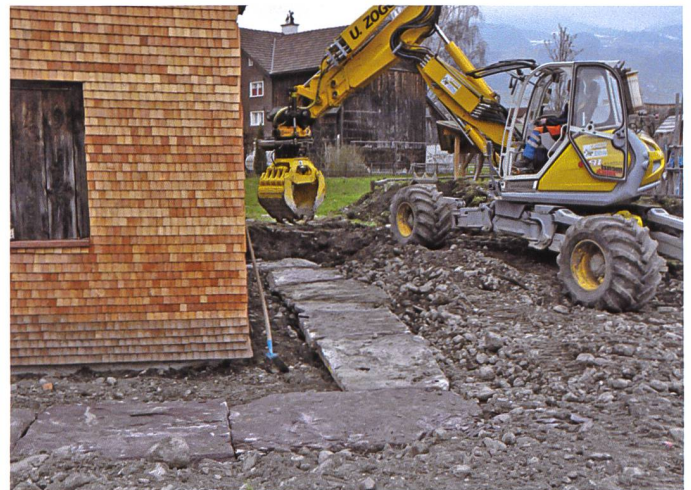
3. April 2013: Bei den Umgebungsarbeiten werden alte Melser- oder Verrucanoplatten für den Fussweg verlegt.
