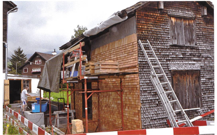
3. Juli 2012: Die Südseite der Messerschmitte ist schon bald fertig geschindelt.
