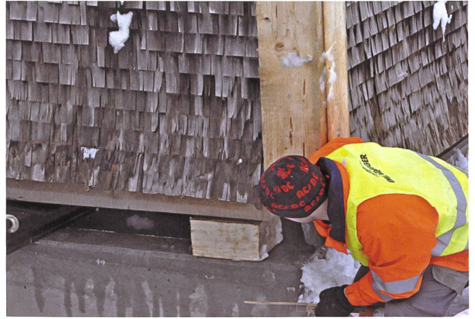
21. Dezember 2011: Millimetergenau wird die Messerschmitte auf das Fundament am neuen Standort gesetzt.
