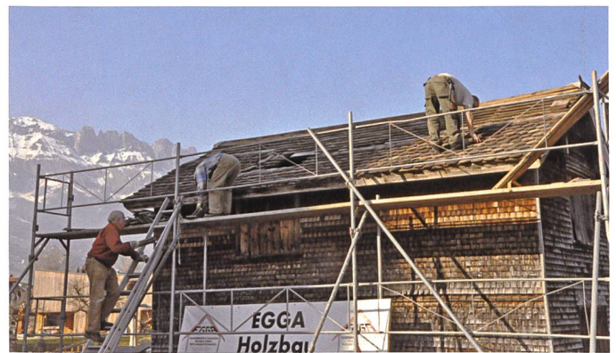
14. März 2012: Nach einem langen Winter heisst es im Frühling das Dach neu eindecken.
