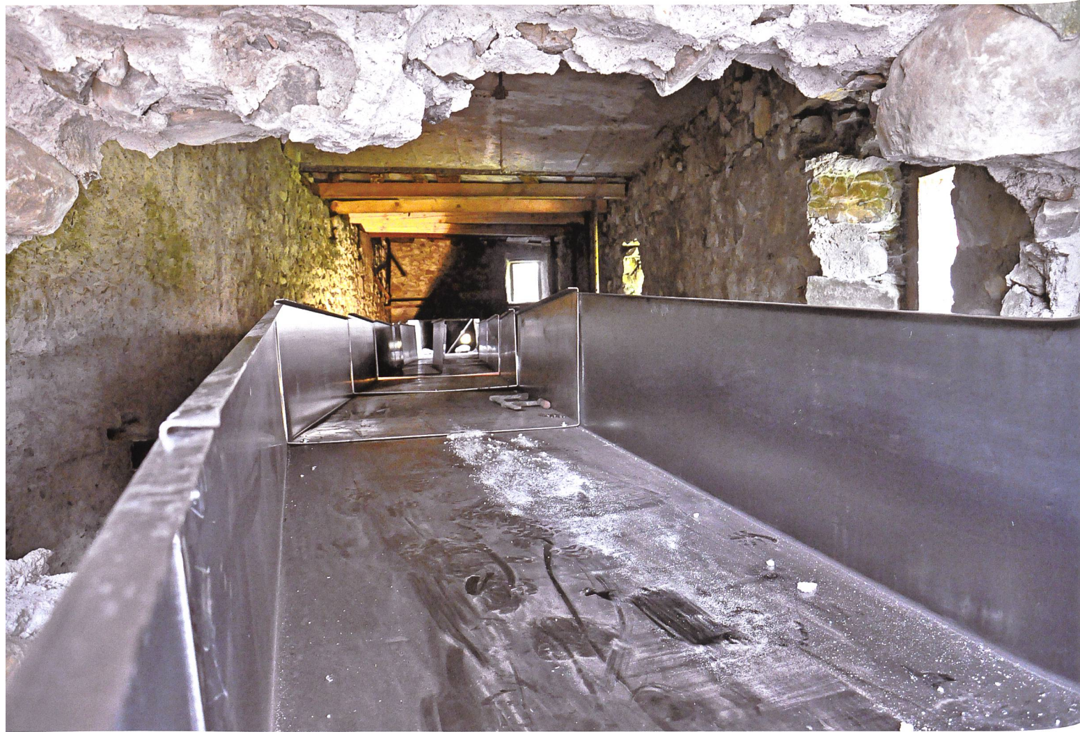
15. Mai 2012: Im Gehlerhaus wird das neue Kett verlegt, damit das Wasser zur Messerschmitte gelangt.
