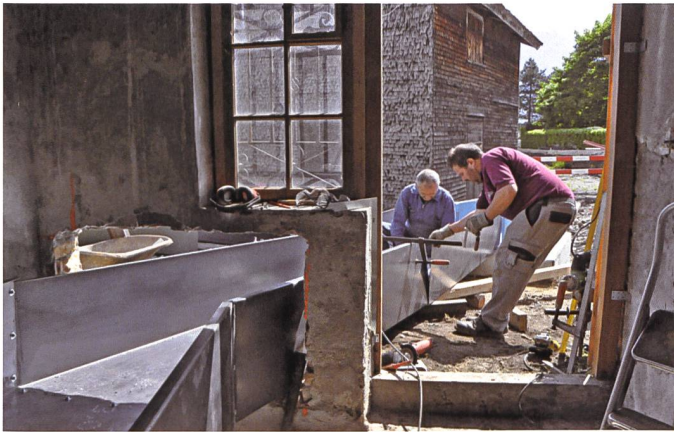
15. Mai 2012: Zwischen Gehlerhaus und Messerschmitte nimmt der Kanal Gestalt an.
