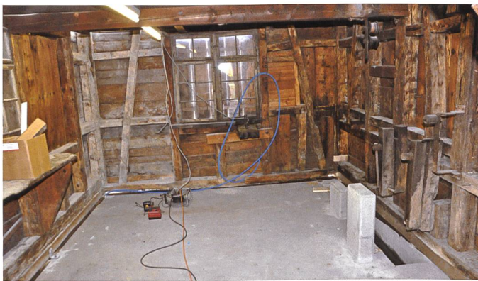
14. März 2012: Im Innern werden Vorbereitungen für die ersten Einbauarbeiten getroffen.
