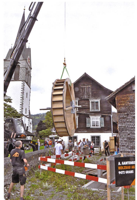
11. Juli 2012: Das neue Wasserrad aus der Wagnerei Oehrli in Lauenen bei Gstaad im Anflug.
