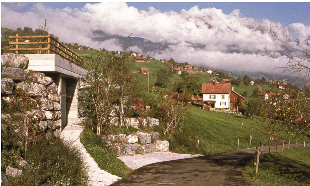
Von aussen ist nicht ersichtlich, dass das Reservoir Perdell (Ampadell) auf rund 530 m ü. M. mit 1300 m 3 Trink- und Brauchwasser sowie 500 m 3 Löschwasserreserve das grösste Reservoir der Grabser Wasserversorgung ist.
