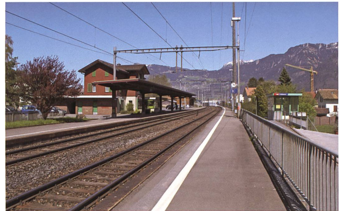
Trübbach erhielt durch den Bau der Sarganserschleife Aussenperrons. Die Gleisanlagen wurden auf ein Minimum zurückgebaut. Für die nächsten Jahre wird Trübbach wohl ohne Zugshalte bleiben. Foto Anton Heer, 25. April 2013
