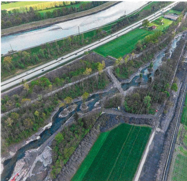
Luftaufnahme der Arbeiten, beide Bachläufe sind sichtbar.
