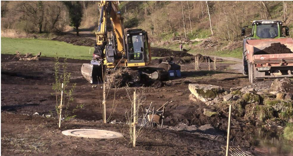
Für die Modellierung der Warm- und Kaltwasserzonen der Feuchtfläche wurden 1200 Kubikmeter Humus und Torf abgetragen und auf den benachbarten Feldern zur Bodenaufwertung ausgetragen. Lehmiges Material fand bei den Wasserflächen als Abdichtung Verwendung.
