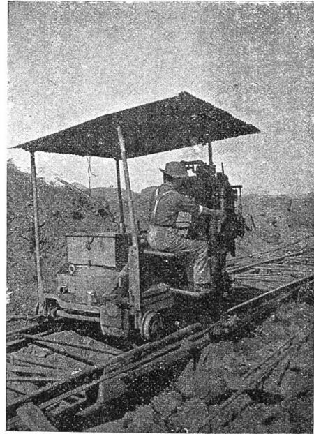
Abbildung 38. Maschine zur Herstellung vertikaler Schlitzte. Antrieb mit Pressluft.
