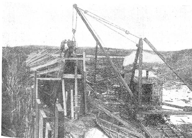
Abbildung 45. Einbringen von Beton in die Schalung der Stützmauer bei Fulton. Erie-Kanal.
