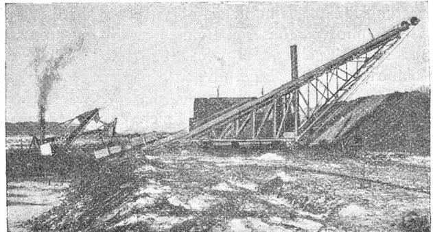
Abbildung 40b. Verschiebbare Schrägbahn. Erie-Kanal.
