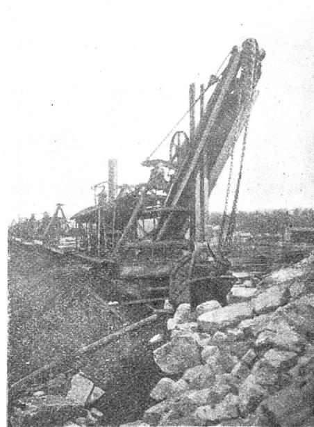
Abbildung 39. Dampfschaufel am Chicago-Entwässerungs-Kanal.
