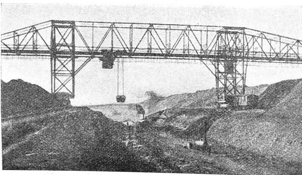
Abbildung 40a. Laufkran beim Bau des Erie-Kanals.
