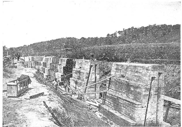
Abbildung 46. Querschnitte von Leitdämmen, Hinter-Ansicht, Cranes Village. Erie-Kanal.
