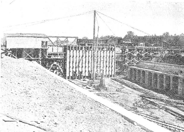
Abbildung 44. Beton Misch-Anlage, Schleuse bei Waterford. Erie-Kanal.
