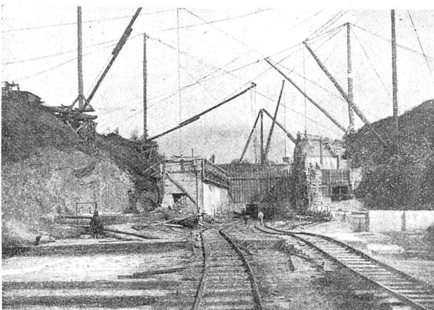
Abbildung 50. Schleuse Waterford, Beton-Boden, von unten gesehen. Erie-Kanal.
