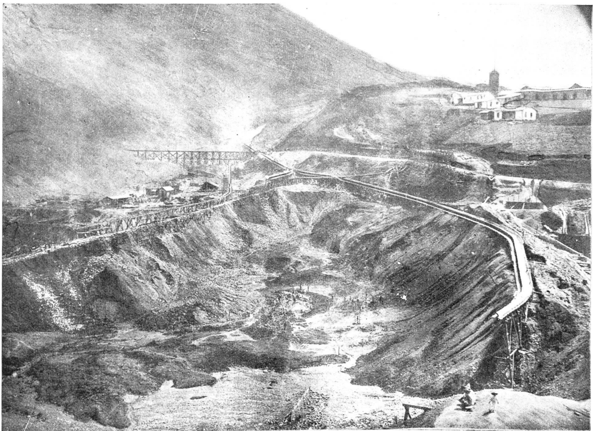
Abbildung 3. Stehengebliebener unterer Fuss des Staudammes und Bresche im Dammkörper direkt nach der Katastrophe am 20. Mai 1909, von Süden aus gesehen.
