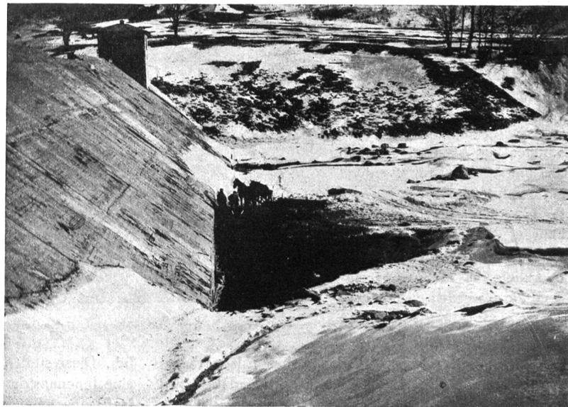
Abbildung 8. Pittsfield-Staudamm nach der Unterspülung, von der Wasserseite gesehen.
