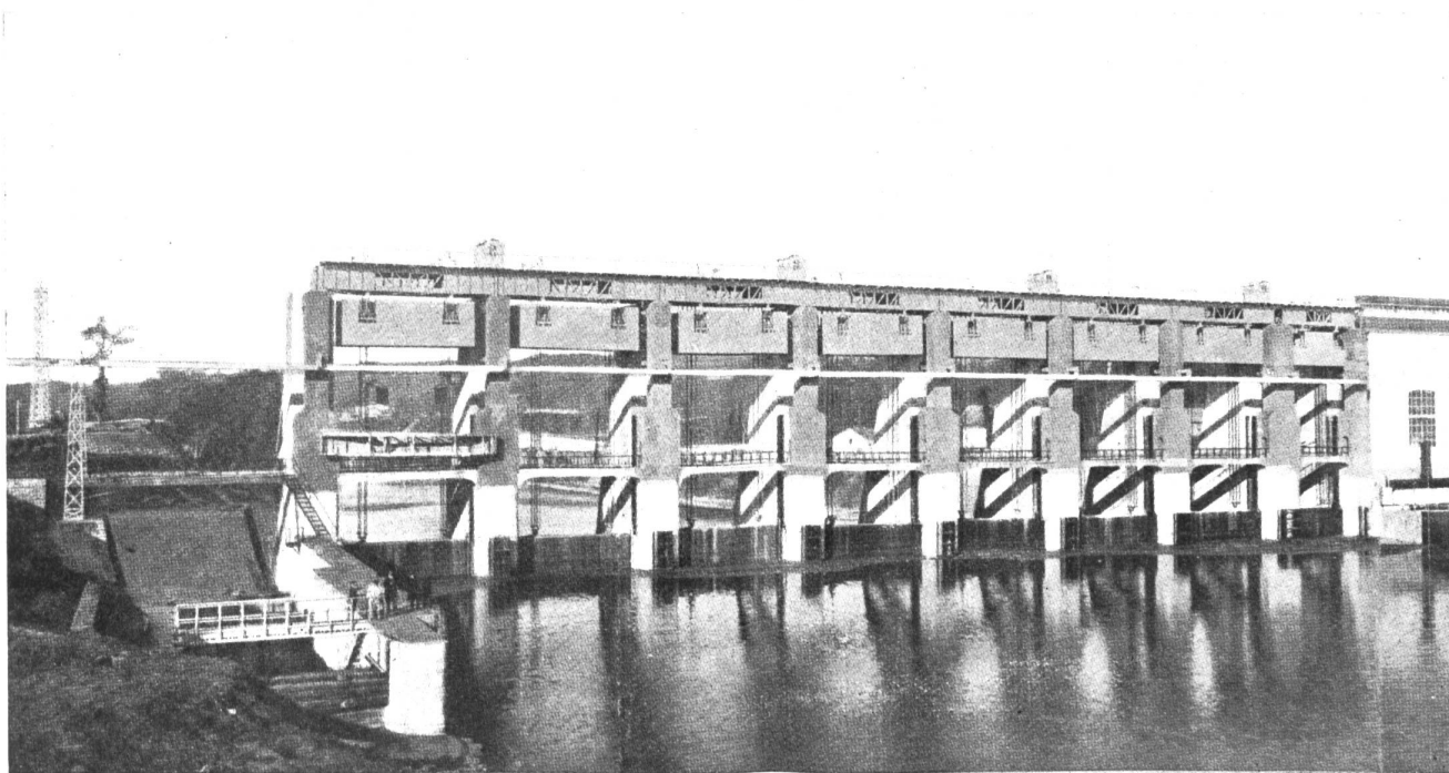
Stauanlage der Usine Hydroélectrique de Tuilière sur la Dordogne (Frankreich).
