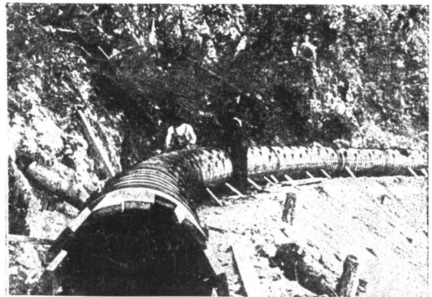
Abbildung 1. Hölzerne Druckleitung in Nordamerika (im Bau).
