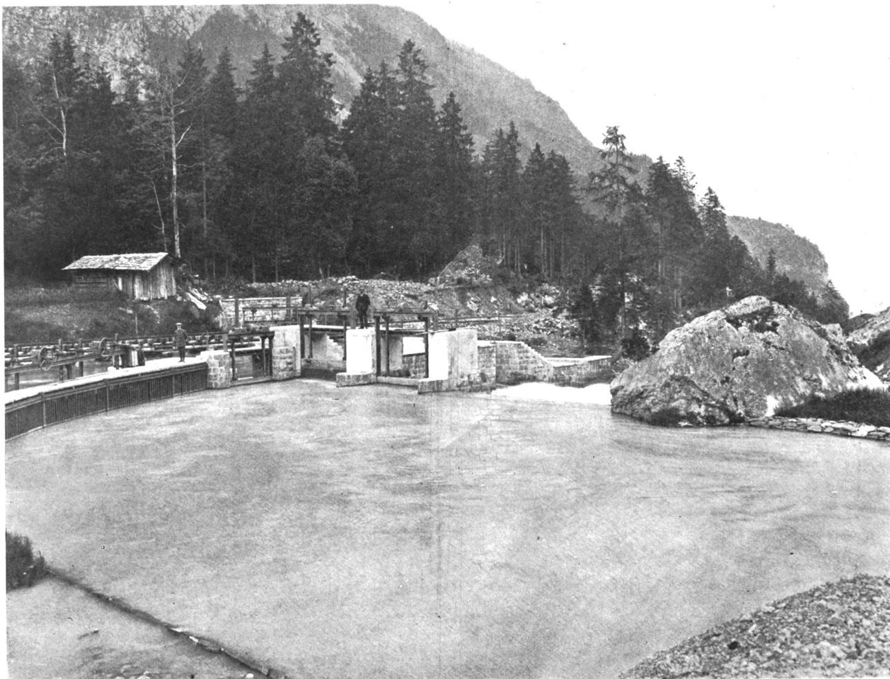
Abbildung 4. Wehranlage mit Wasserfassung. Ansicht von oben. Links Sommer- und Wintereinlauf.
