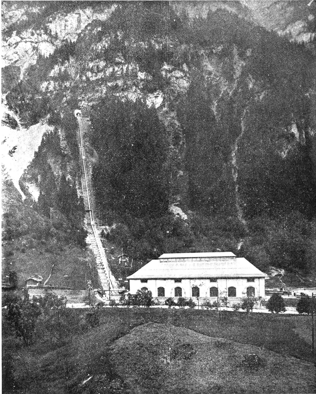
Abbildung 7. Elektrizitätswerk Kandergrund. Ansicht von Druckleitung und Maschinenhaus.
