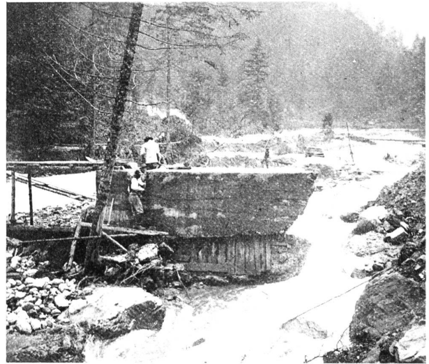
Das Alvierwerk. Abbildung 7. Das hinterspülte Stauwehr.
