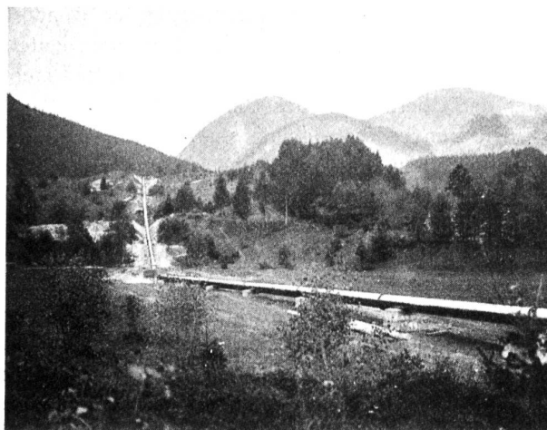
Das Alvierwerk. Abbildung 15. Blick auf den mittleren Teil der Rohrleitung.
