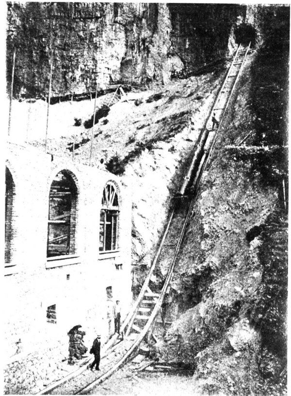
Das Alvierwerk. Abbildung 19. Seilbahn für den Rohrtransport.
