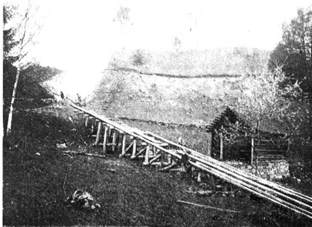
Das Alvierwerk. Abbildung 20. Holzrampe für den Rohrtransport.
