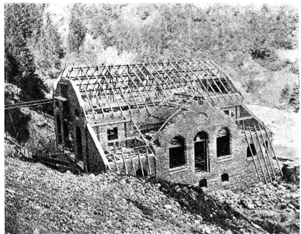
Das Alvierwerk. Abbildung 22. Das Turbinenhaus im Bau.
