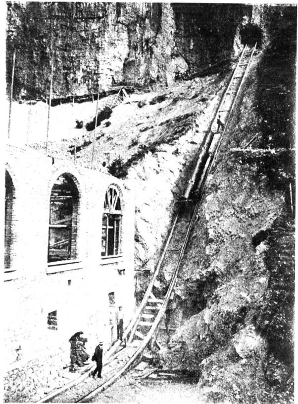
Das Alvierwerk. Abbildung 19. Seilbahn für den Rohrtransport.
