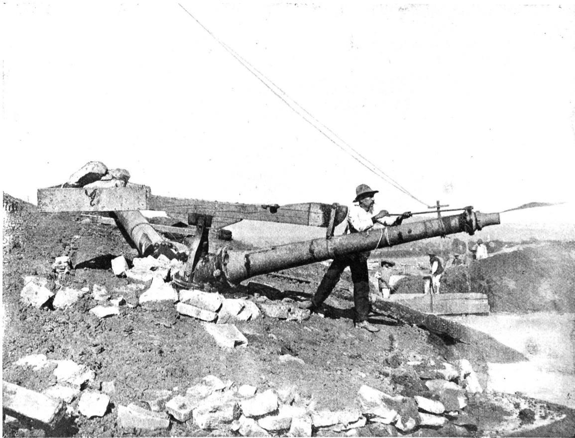
Der Necaxa-Damm. — Figur 2. Hydraulischer Monitor in Tätigkeit.
