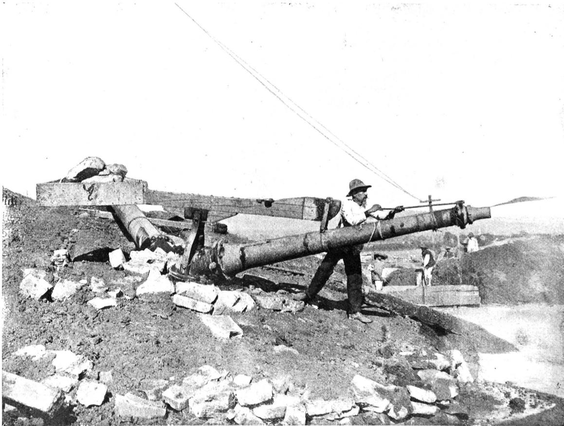
Der Necaxa-Damm. — Figur 2. Hydraulischer Monitor in Tätigkeit.
