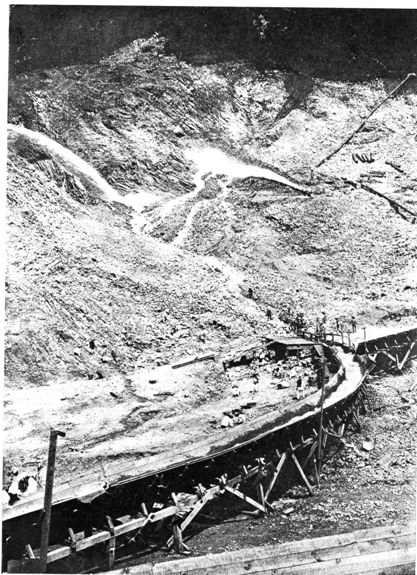
Der Necaxa-Damm. Figur 5. Schwemmen im Steinbruch und Einlauf eines offenen Kanals.
