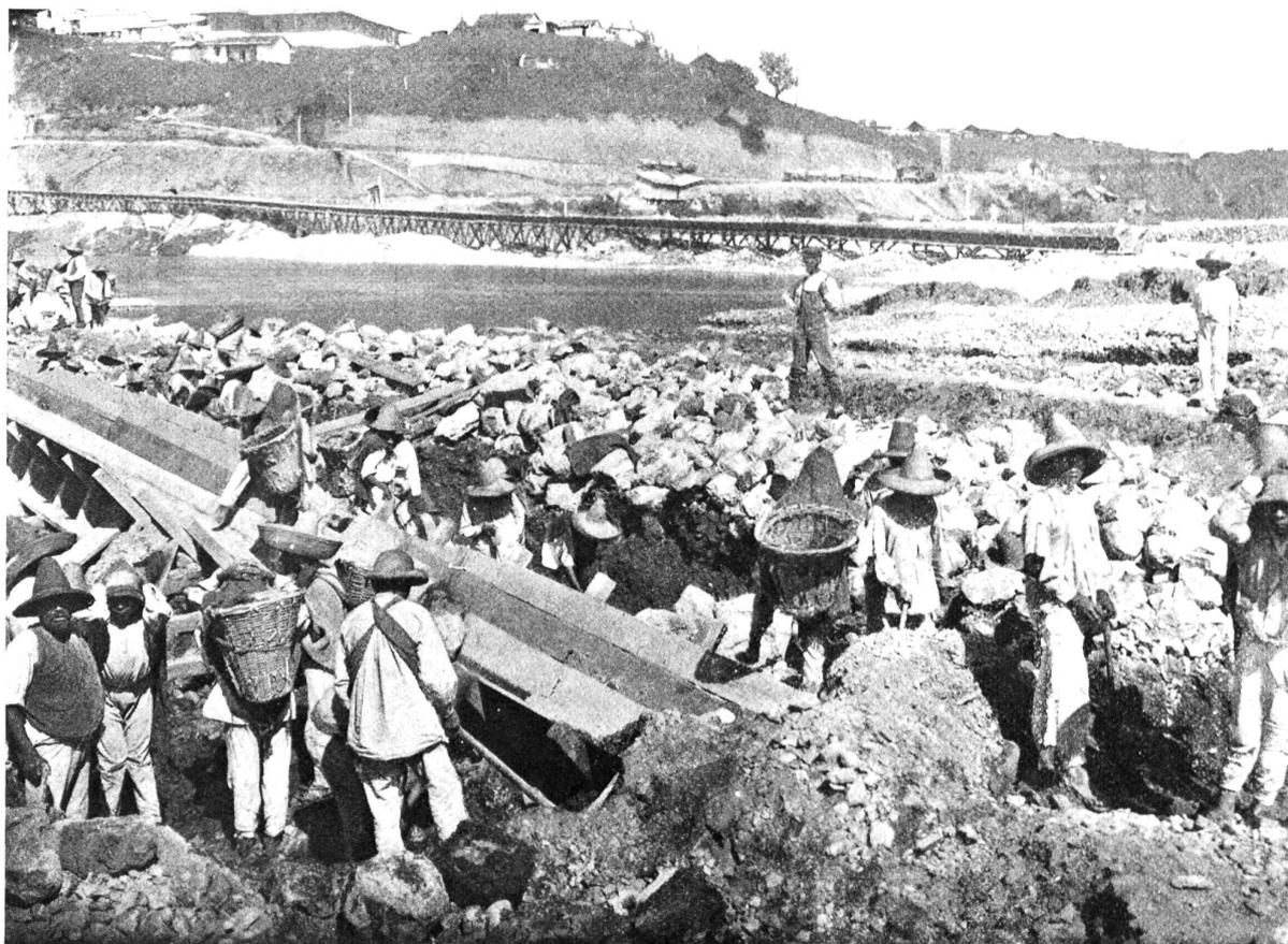
Der Necaxa-Damm. Figur 9. Freilegen einer eingegrabenen Kanalarinne.
