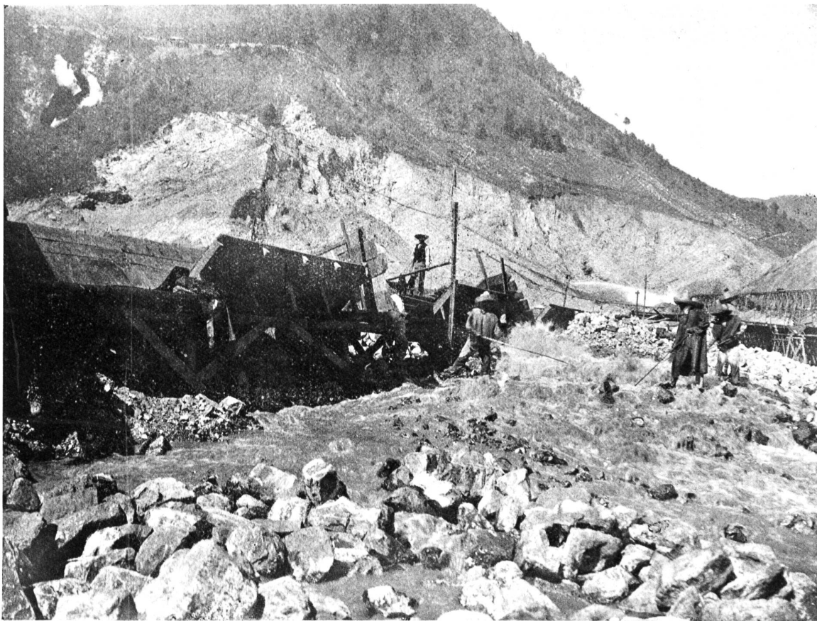
Der Necaxa-Damm. Figur 10. Kanal mit Seitentüren im Betrieb.
