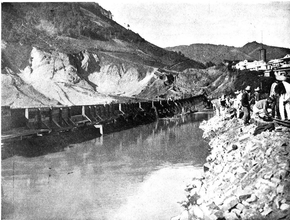
Der Necaxa-Damm. Figur 11. Rechteckiger Kanal zum Einschwemmen des Lehms und der Tepetate.
